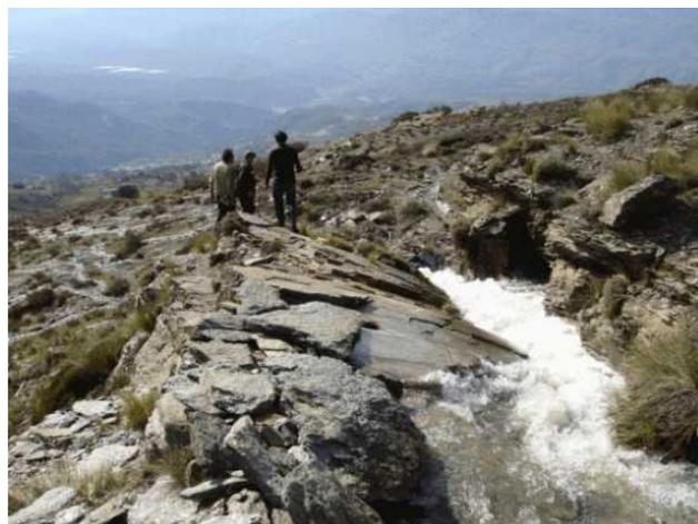
Fotografía de una acequia de careo, dispositivo para la recarga artificial de acuíferos existentes en Sierra Nevada (véase <http://www.agua2013.es/agua-y-tecnologia>).
