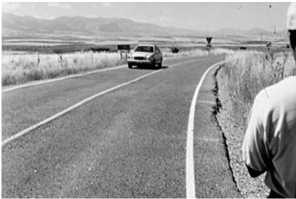
Figura 6. Segundo tramo experimental de carretera de HPAP de 2,7 km de longitud, construido con extendidora de doble tamper y sin pasadores, en el término municipal de Zamarramala – Segovia, con peraltes a derecha e izquierda y pendiente > 7% (1997): Otra panorámica.
