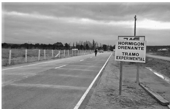
Figura 1. Primer tramo experimental de carretera de Hormigón Poroso de Altas Prestaciones (HPAP) de 270 metros de longitud, construido con extendidora de tamper simple de aglomerado asfáltico y con pasadores en Gudino, término municipal de Villamayor, Salamanca (1995).
