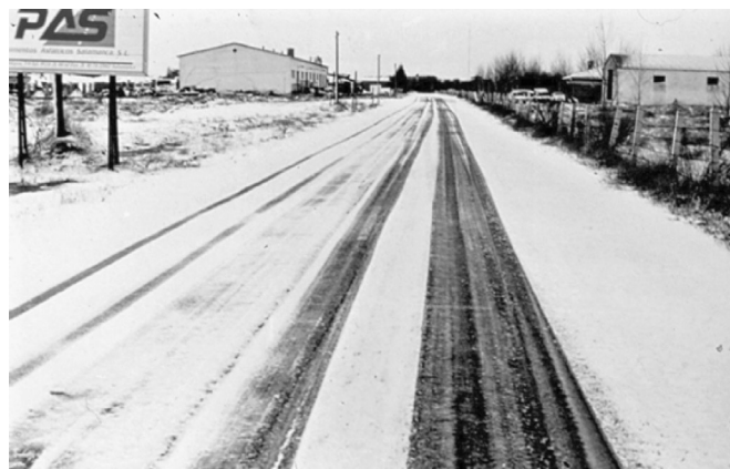
Figura 3. Estado del primer tramo experimental de carretera de Hormigón HPAP de la figura 1 tras una nevada.
