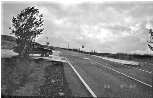
Figura 7. Aspecto del segundo tramo experimental de carretera de HPAP de las figuras 5 y 6, en un día con lluvia, en su unión con la carretera al vertedero de Segovia sito en el término municipal de Zamarramala (1998). Superficie brillante: Aglomerado asfáltico convencional. Superficie Opaca: HPAP.
