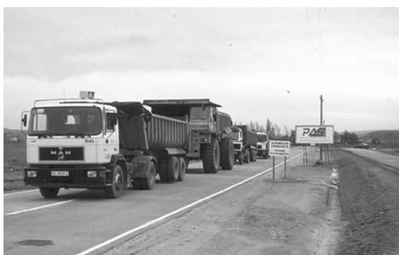
Figura 2. Prueba de carga en el primer tramo experimental de carretera de HPAP de la figura 1 (1995).
