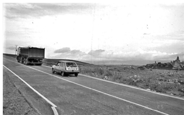
Figura 5. Segundo tramo experimental de carretera de HPAP de 2,7 km de longitud, construido con extendidora de aglomerado asfáltico de doble tamper y sin pasadores, en el término municipal de Zamarramala, Segovia, con peraltes a derecha e izquierda y pendiente > 7% (1997): Una panorámica.
