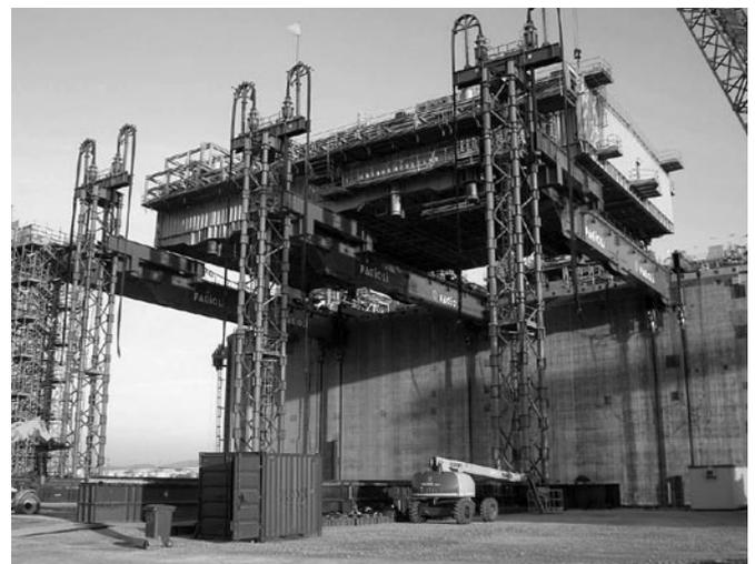
Instalación de uno de los módulos encima de la GBS mediante el sistema de elevación
