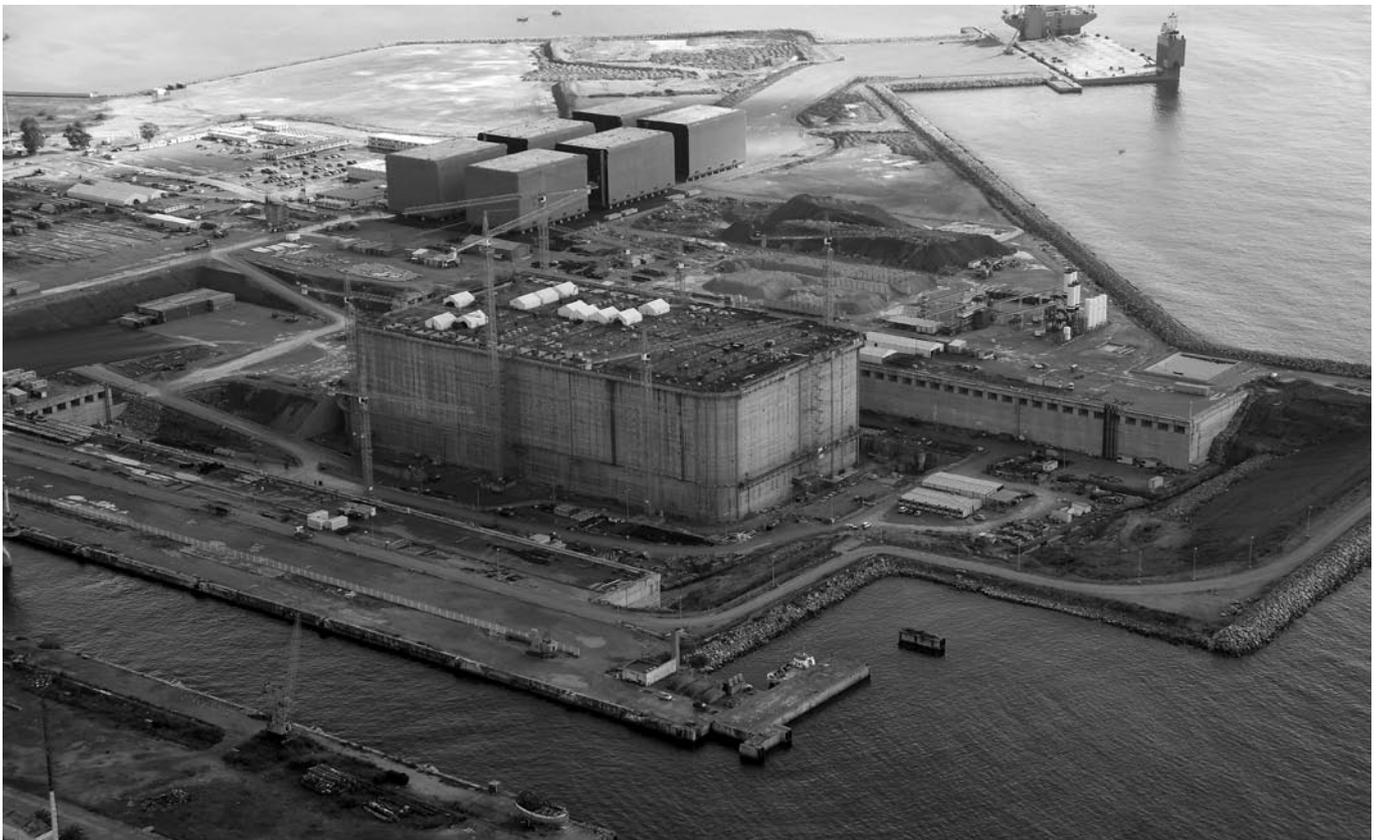
La construcción de la GBS, y detrás las secciones de los tanques de almacenamiento acopiados temporalmente
