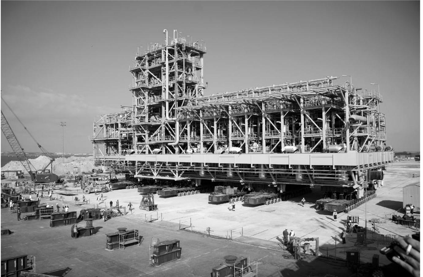
El módulo de vaporización durante la operación de carga para transporte a Argel
