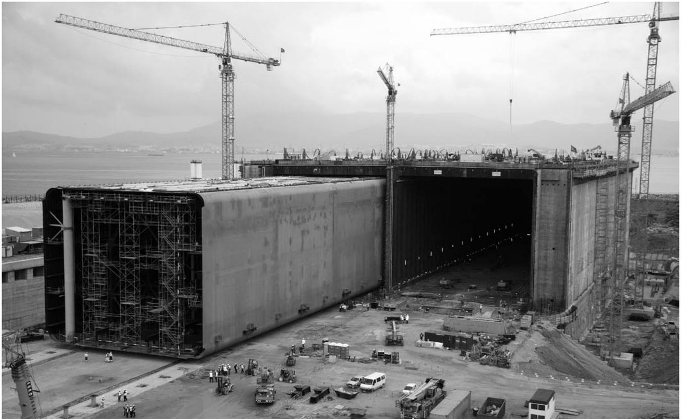
Instalación de tanques de almacenamiento en el interior de la GBS
