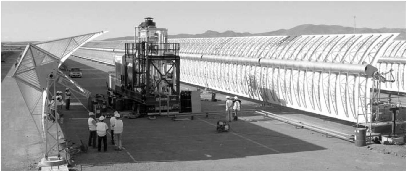
Instalación de lazos de colectores con el sistema SENERtrough en la planta de Andasol 1.
